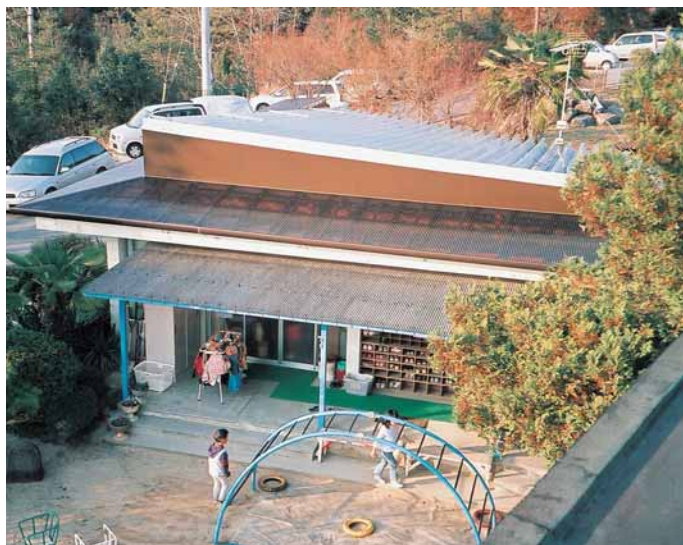
屋根内に断熱材を入れ、波板も新調した「ひまわりの園」。
